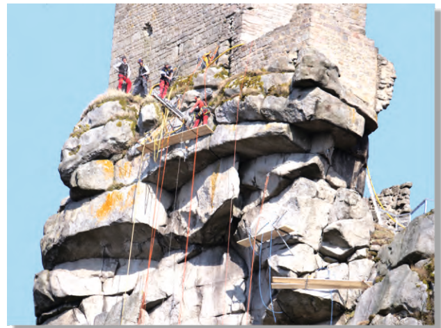
Sicherungsarbeiten an den Felsen 2022
