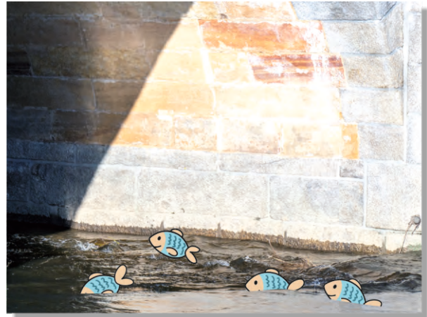
Granitquader am Pfeiler der Brücke
